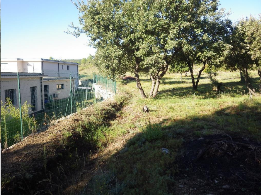
Entonnement combe dans canalisation
