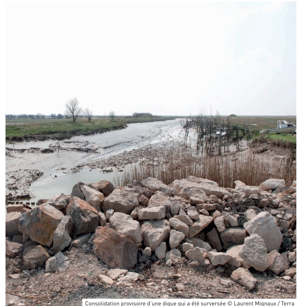
Consolidation provisoire d'une digue qui a été surversée © Laurent Mignaux / Terra
