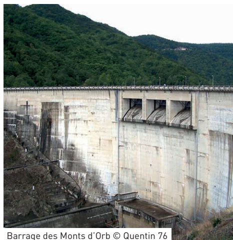
Barrage des Monts d'Orb © Quentin 76
