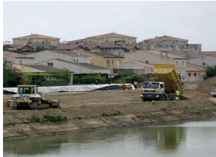
Réfection des digues du Lez au droit des secteurs urbanisés de Lattes dans le cadre du PAPI du bassin versant du Lez © SYBLE
