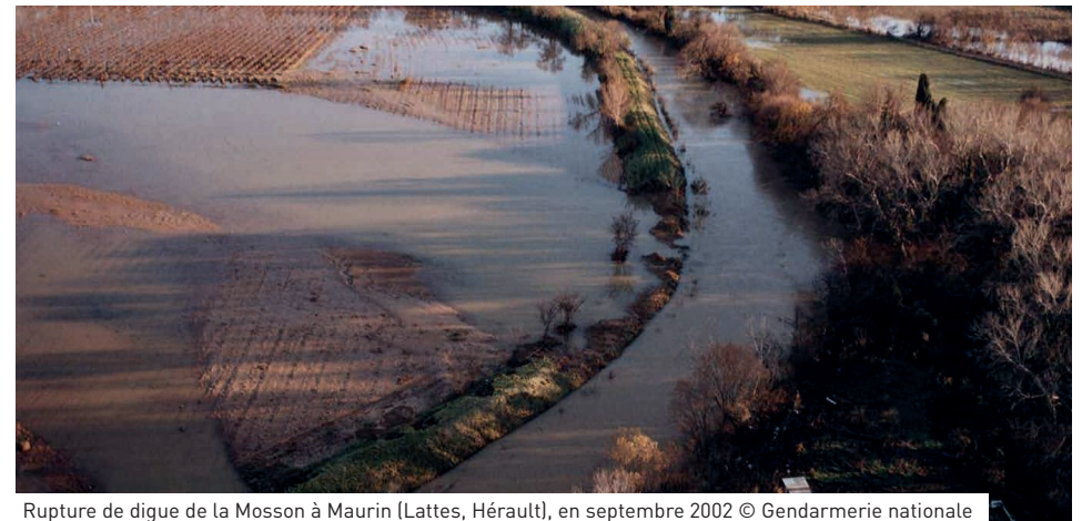
Rupture de digue de la Mosson à Maurin (Lattes, Hérault), en septembre 2002 © Gendarmerie nationale
