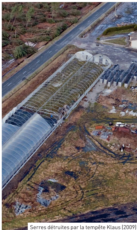
Serres détruites par la tempête Klaus (2009)
