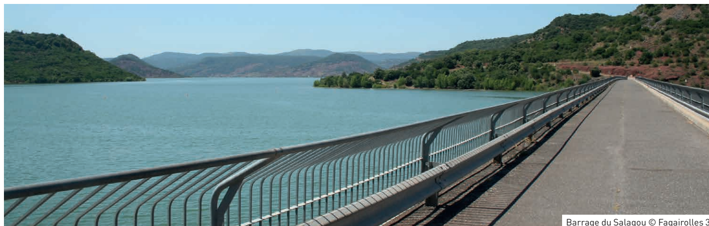
Barrage du Salagou © Fagairolles 34
