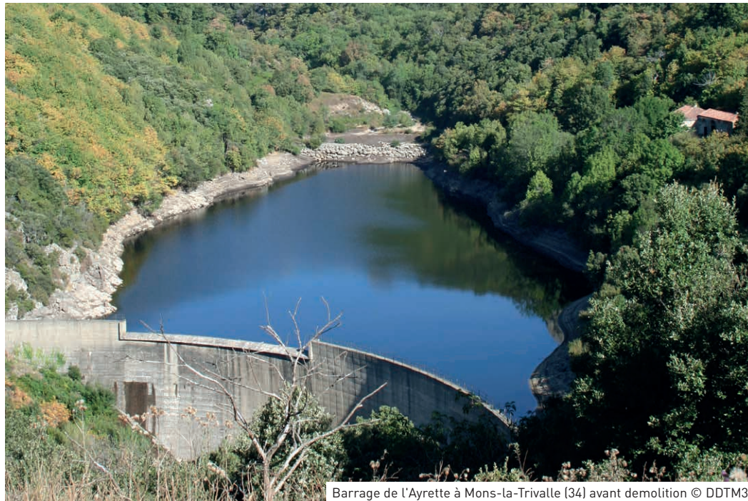
Barrage de l'Ayrette à Mons-la-Trivalle (34) avant demolition © DDTM34
