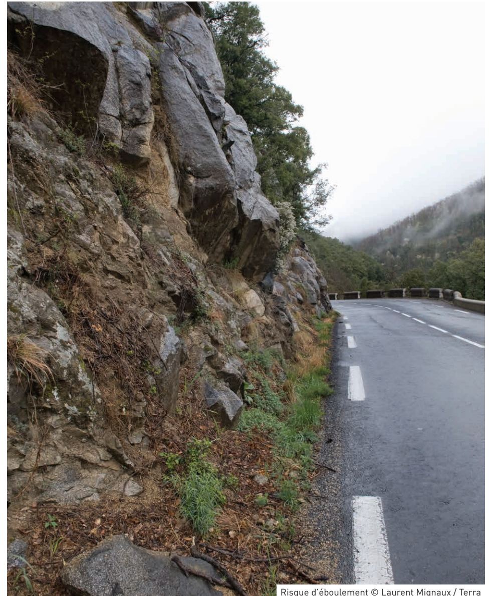
Risque d'éboulement © Laurent Mignaux / Terra
