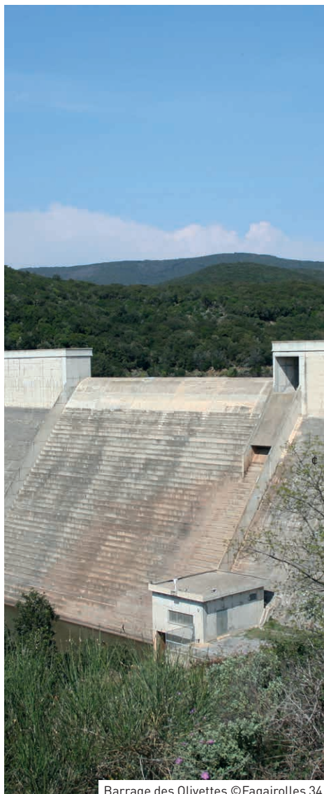
Barrage des Olivettes ©Fagairolles 34
