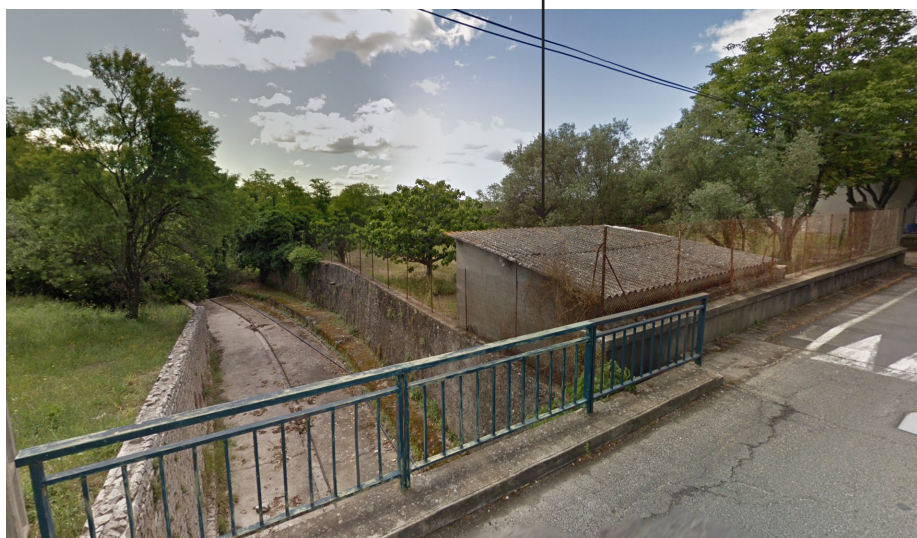
Vue sur le site concerné par la 2ème Modification // ruisseau affluent du Valen.
